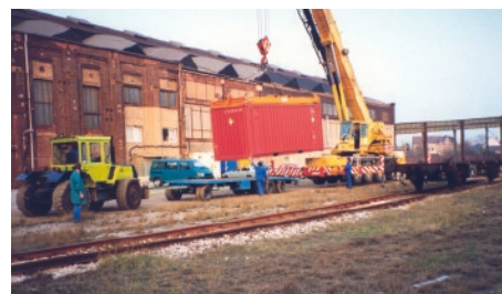
Früher noch mit Autokran: Umladung per Bahn angelieferter Container
