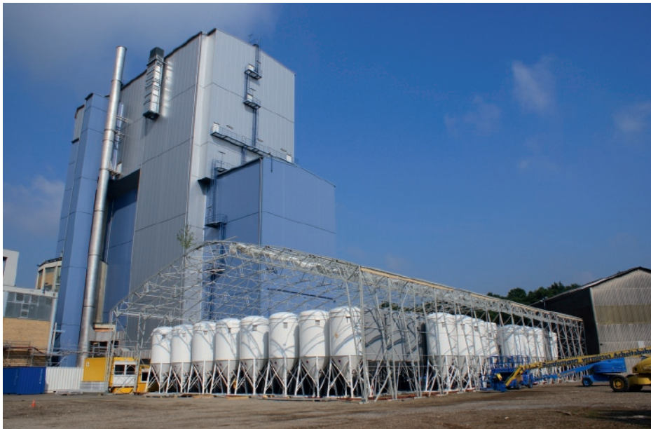
Vorlagebehälter zur Herstellung des Porenleichtbetons
