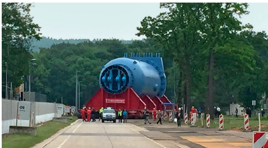
Abtransport des Reaktorbehälters im Mai 2015
