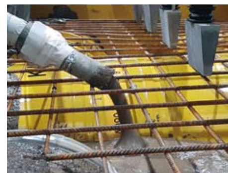
Betonierung mit Niederhalter.
