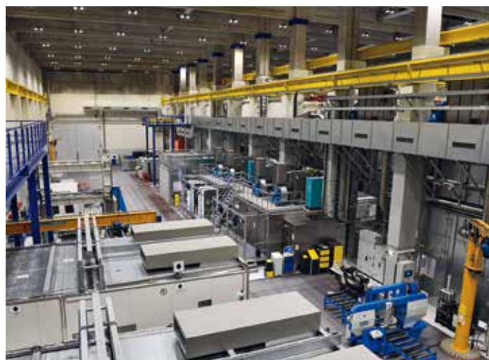
Das Reststoffbearbeitungszentrum Philippsburg. Foto: EnBW
