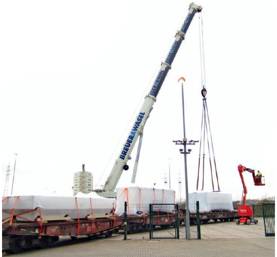
In Folie verpackt – Anlieferung von drei der bis zu 73 Tonnen schweren Betonriegel in Duisburg
