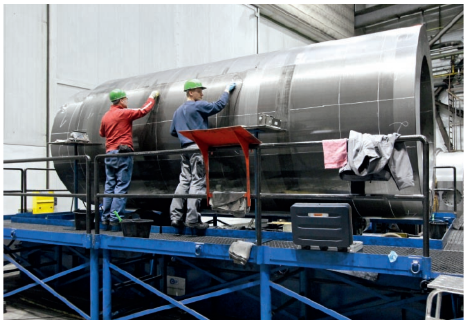
Ultraschallprüfung des Behälterkörpers beim Zulieferer Gontermann-Peipers in Siegen
