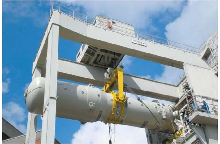
Ausbau eines Dampferzeugers im Kraftwerk (links) – Nach dem Ausschleusen gut zu erkennen: der eigens für den Transport angebrachte Schutzanstrich.
