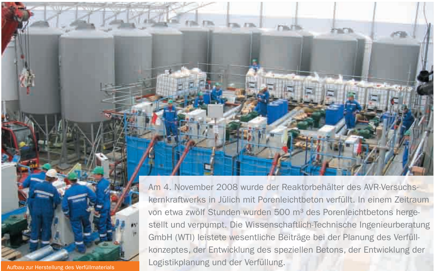
Aufbau zur Herstellung des Verfüllmaterials
