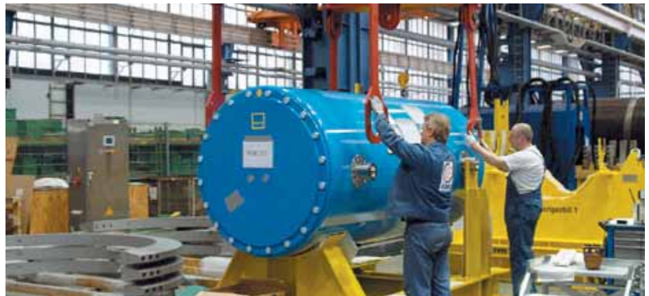
Vorbereitungen für den Transport des ersten CASTOR® KNK zur Kalthantierung
