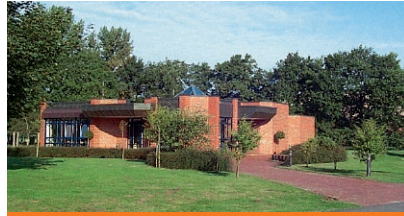
Das Informationshaus direkt vor der Anlage
