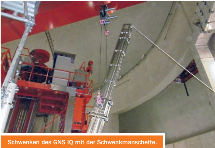
Einbringen des GNS IQ in die Übergabestation im BE-Lagerbecken.
