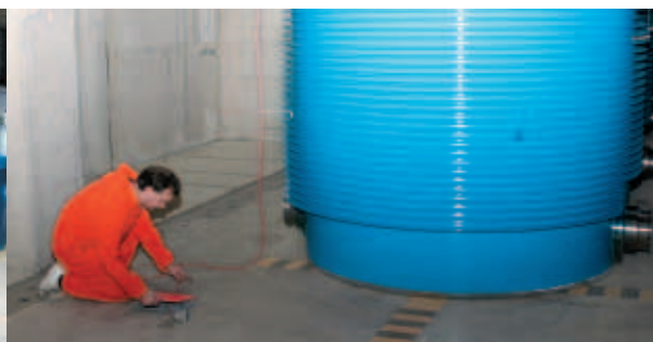
Anschluss eines CASTOR® HAW 20/28 Behälters an das Behälterüberwachungssystem über eine Steckverbindung im Hallenboden.
