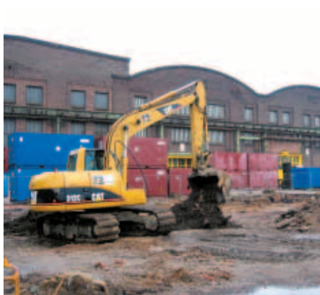
Die Bauarbeiten haben im Mai 2007 begonnen
