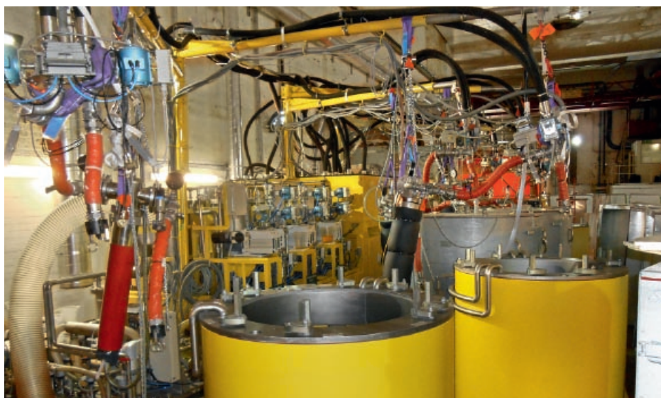
Bereit für ihren Einsatz: die FAVORIT in der ehemaligen Turbinenhalle in Bradwell.
